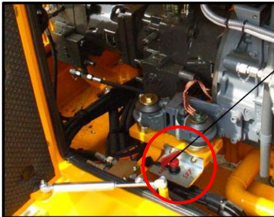
Interruptor-seccionador de la batería
