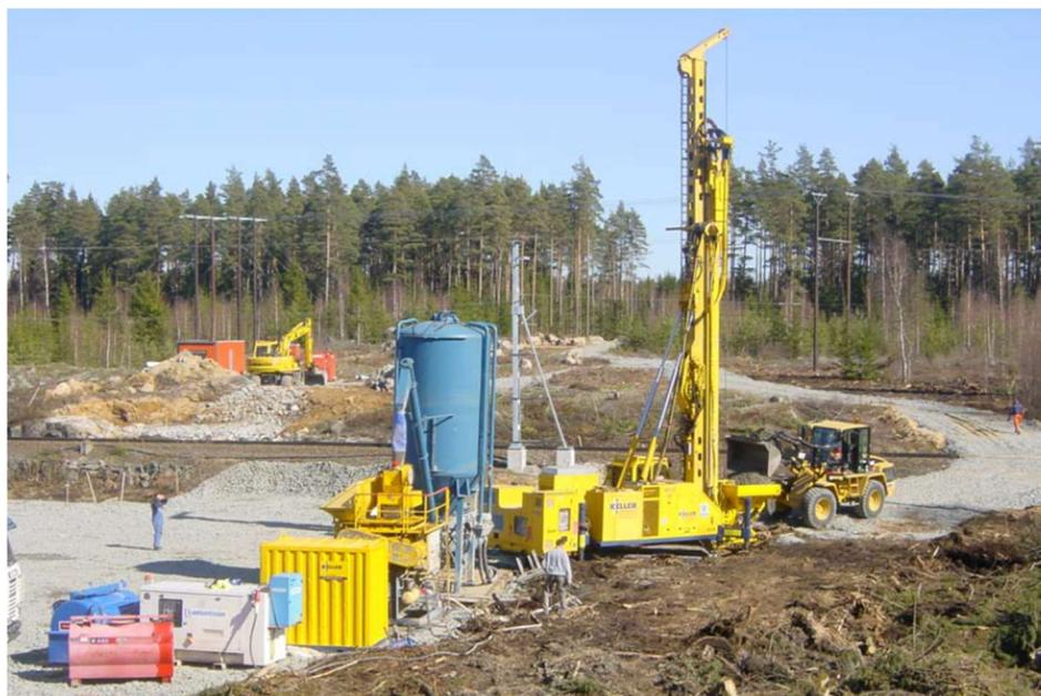
Figura 12. Execução de colunas de brita em Frövifors, Suécia.
